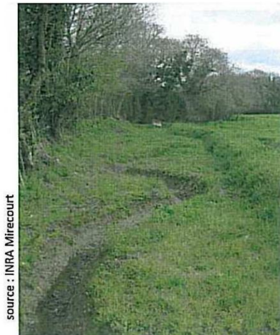
Figure 9 : Exemple d'aménagement de sortie de drain par un fossé sinueux
