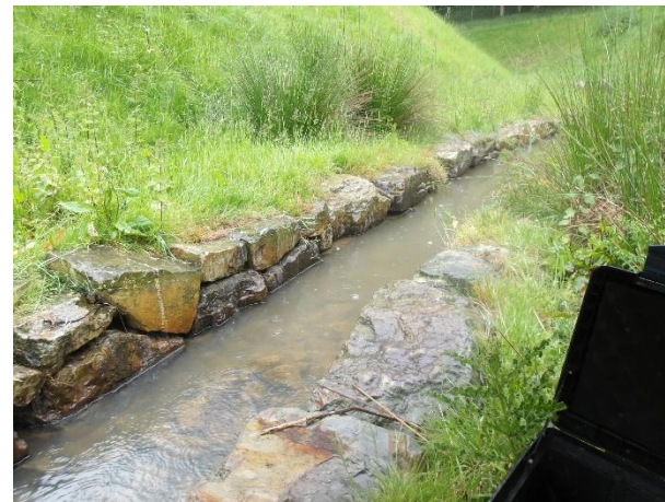
Vu depuis l'amont, au niveau des anciens ouvrages hydrauliques du plan d'eau, 21/05/2025
