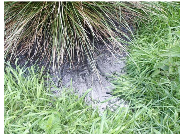
Boues s'accumulant sur les héliophytes en sortie de rejet, 05/05/2025
