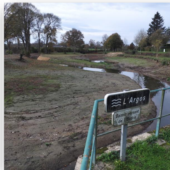
Après travaux (L'Argos reméandrée)
