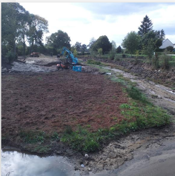
Pendant les travaux
