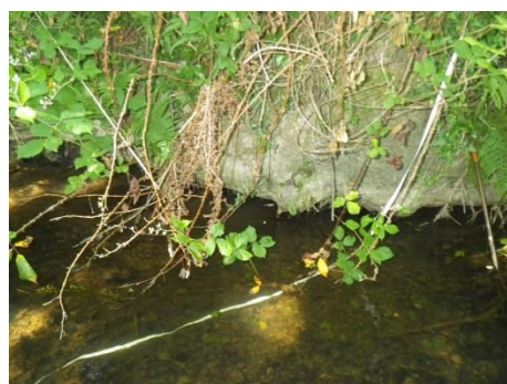
Présence d'une sous-berge
