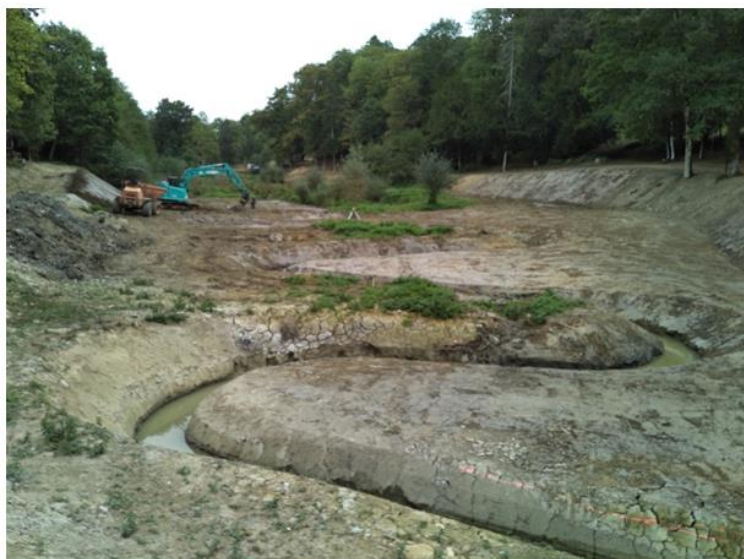
Travaux d'aménagements sur la Ridelais en 2022
