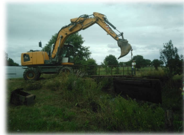
Effacement du clapet de Vezeuvres sur l'Argos à Chazé sur Argos
