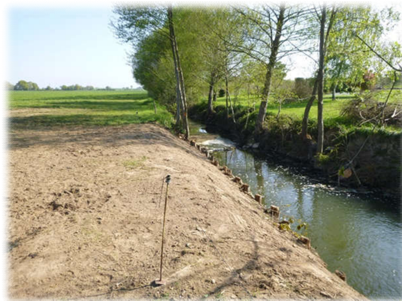
Protection en génie végétale sur l'Argos à Chazé sur Argos
