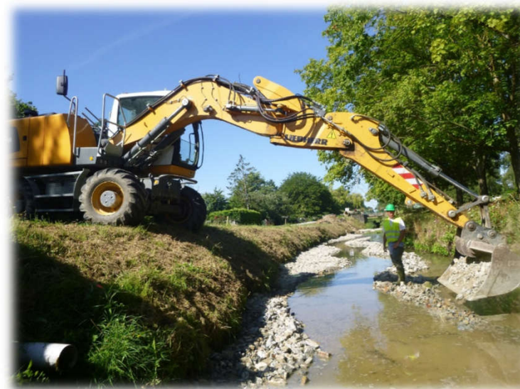
Restauration de l'Argos à Chazé-sur-Argos
