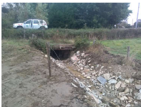
Travaux de restauration du lit mineur
