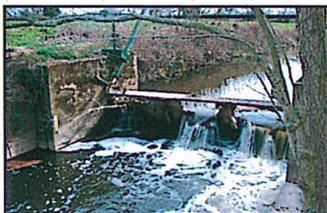
Clapet percé sur l'Argos
