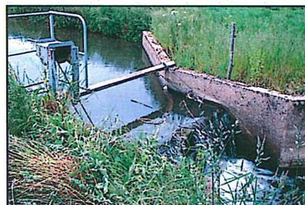
Barrage à clapet sur l'Araize
