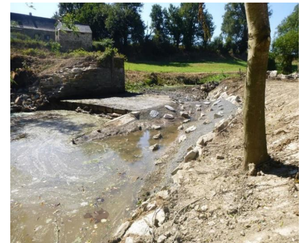
Rampe en enrochements à Sorin (Noëllet)
