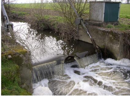
Clapet semi-automatique à vérin
