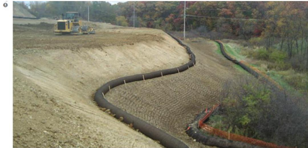
Approche multi-barrières appliquée à un talus décapé : lutte contre l'érosion par chenillage des sols, infiltration des écoulements superficiels à l'aide de boudins de rétention en série, maintien d'une zone tampon entre le chantier et le cours d'eau par mise en défens de la ripisylve
