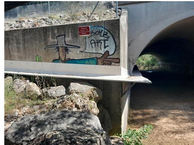
Mise en place de passage à petite faune sur ouvrage de franchissement de cours d'eau
