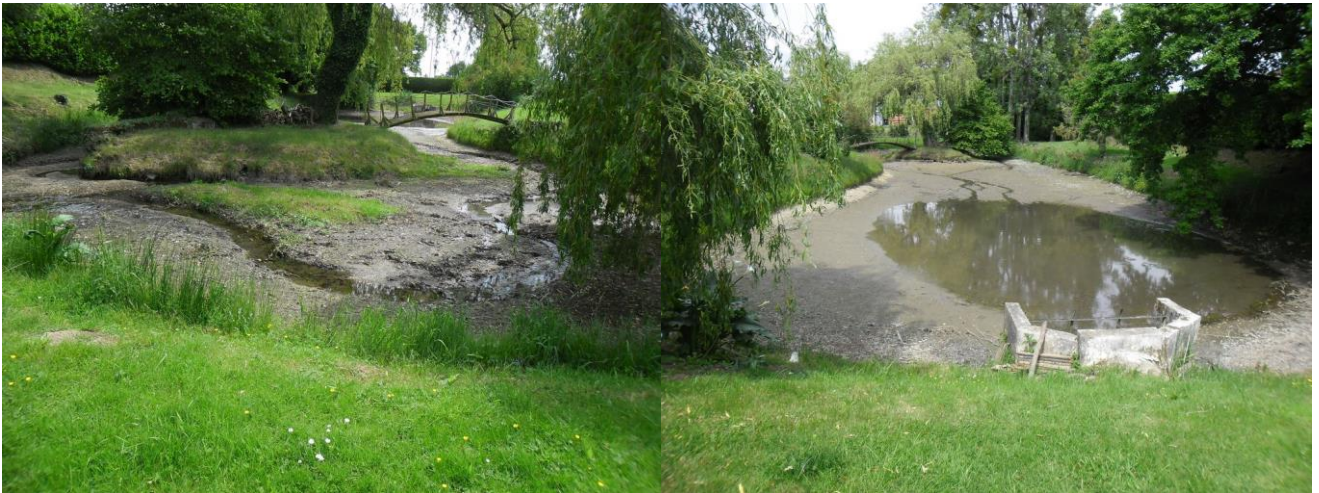
Vue amont et vue aval du plan d'eau vidangé (source : DDT53, 2019)
