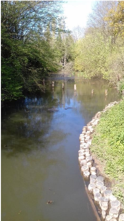
Figure 7 ruisseau de la Martinais
