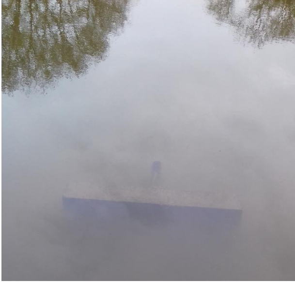
Figure 20 ouvrage de vidange
