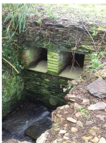
Figure 38 ouvrage en aval
