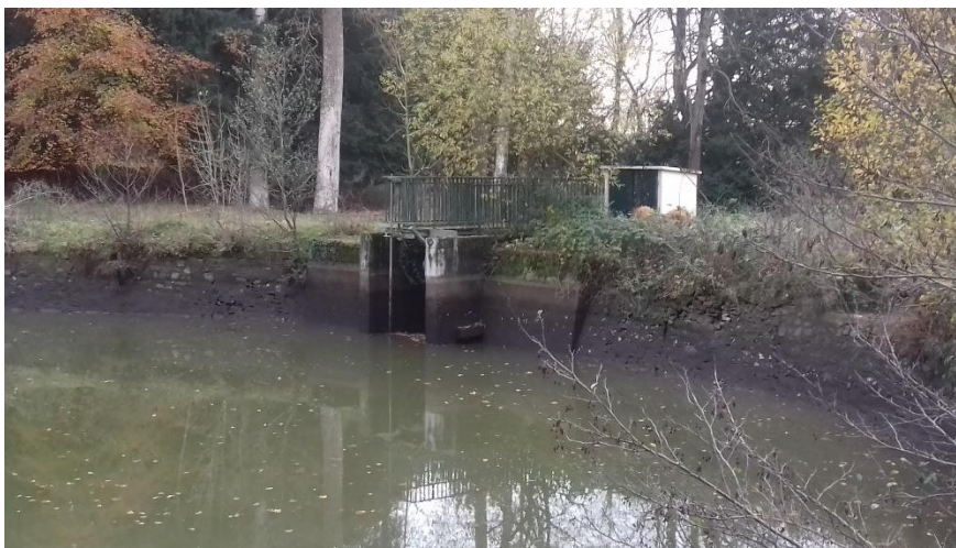
Digue et clapet pendant l'abaissement progressif réalisé sur 15 jours.
