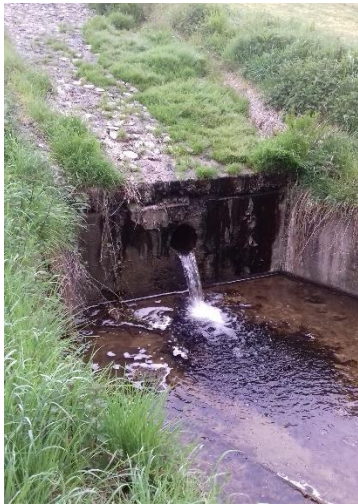
Figure 5 ouvrage en aval du plan d'eau
