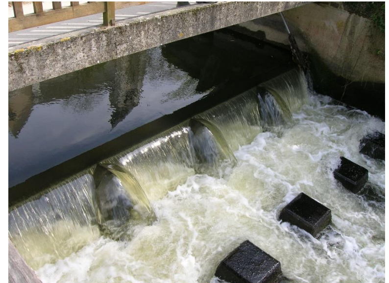
Clapet du Bourg de Craon
