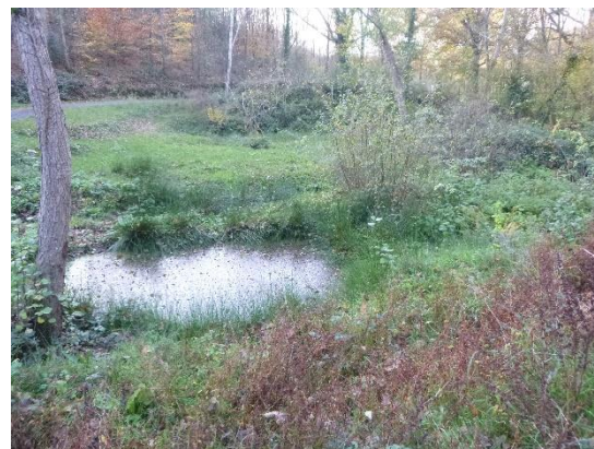
Travaux de restauration de la zone humide du Bois 1
