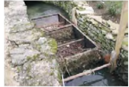
Filtre mobile installé sur un cours d'eau
