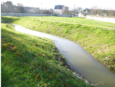
L'Homée après travaux
