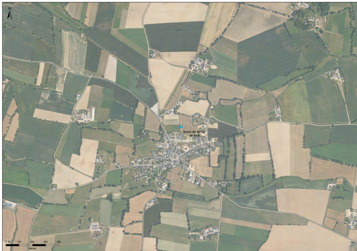
Figure 12 : Localisation du site suivi sur la commune de Pommerieux.
