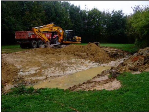
Mare de Ballots en phase travaux
