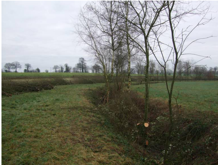
Tronçon de cours d'eau après les travaux d'entretien
