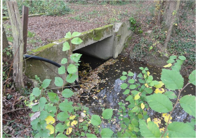
Seuil à madriers (source : Bassin de l'Oudon)
