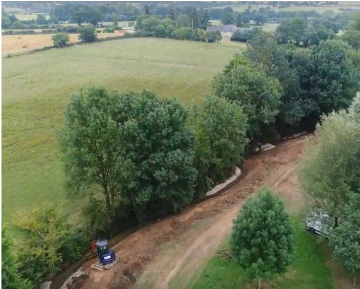
Reprofilage des berges en pentes douces
