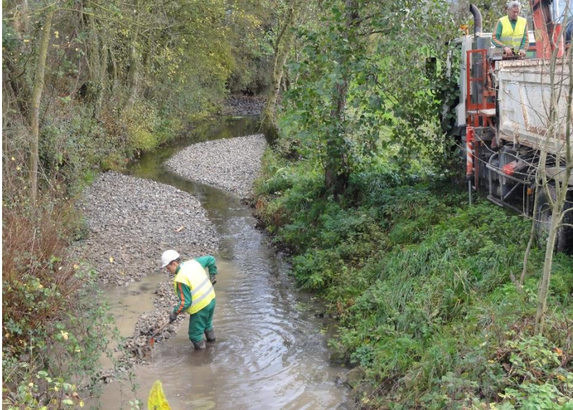
Site de Beauverger pendant les travaux
