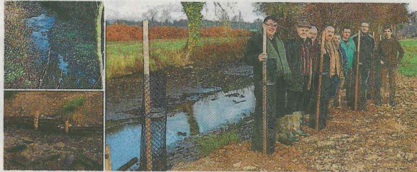
Marans, lundi 5 décembre. Des travaux ont restauré et consolidé les berges de l'Hommée, avant la plantation d'arbres.
