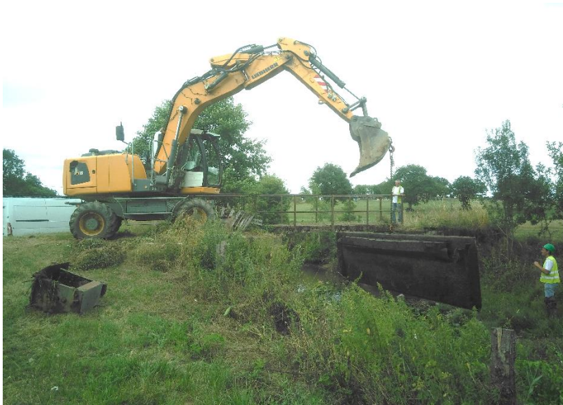
Effacement d'un clapet sur l'Homnée
