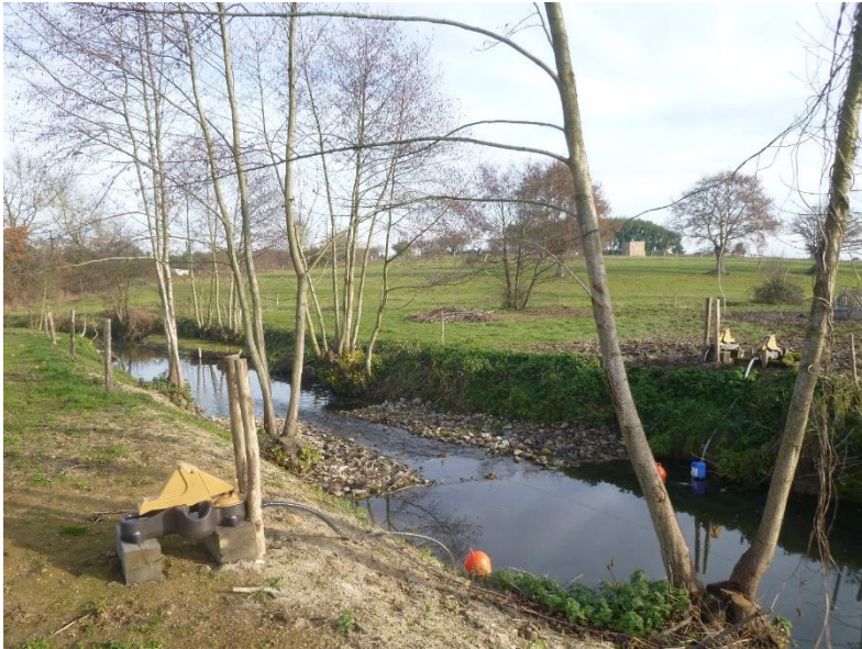
Aménagement d'une pompe d'herbage et d'un radier
