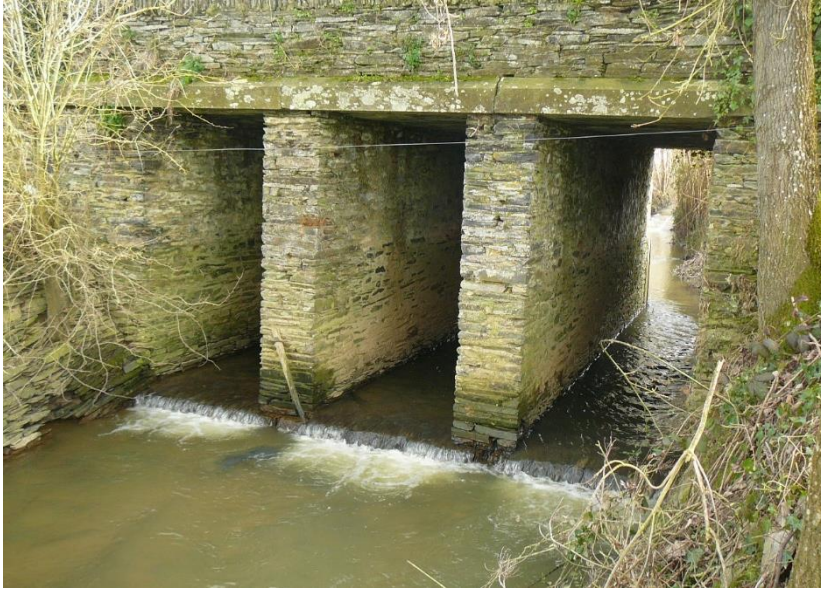
Radier de pont (source : Bassin de l'Oudon)
