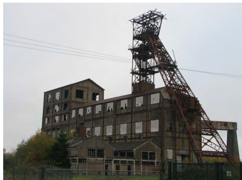
Photo 169 : Carreaux de la mine de fer de Bois II (décembre 2013, Justine BOIVIN)
