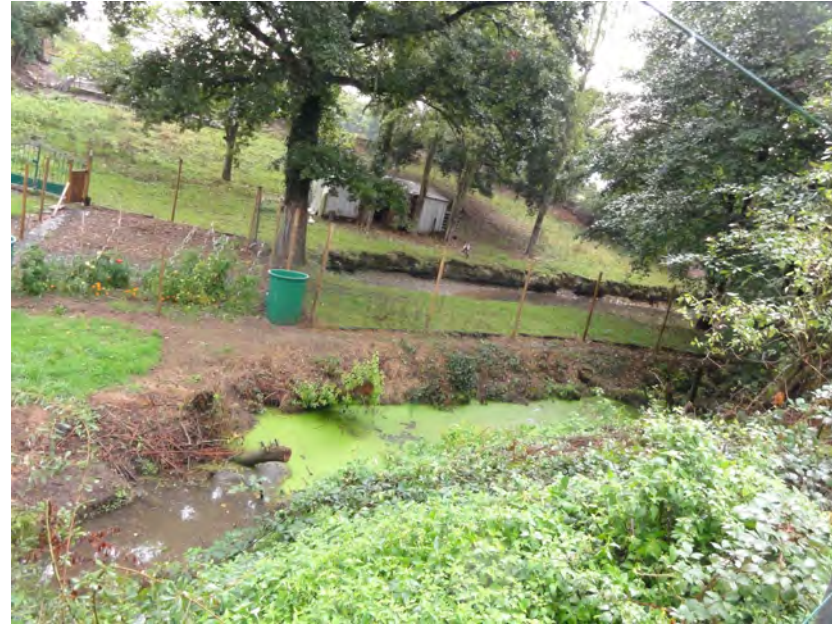
Photo 86 : Sortie de la station d'épuration de la Chapelle aux Pies (octobre 2013, Justine BOIVIN)
