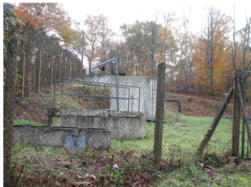
Photo 170 : Station d'épuration aux abords de l'étang de Saint-Blaise (décembre 2013, Justine BOIVIN)
