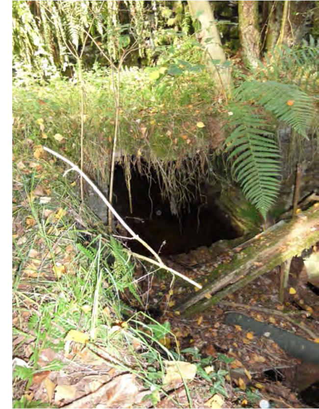
Photo 27 : Station de pompage du terril de Misengrain (septembre 2013, Justine BOIVIN)
