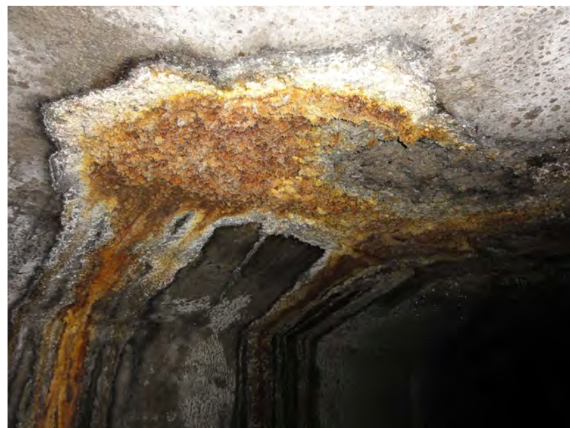
Photo 125 : Tunnel de la Braudaie (octobre 2013, Justine BOIVIN)
