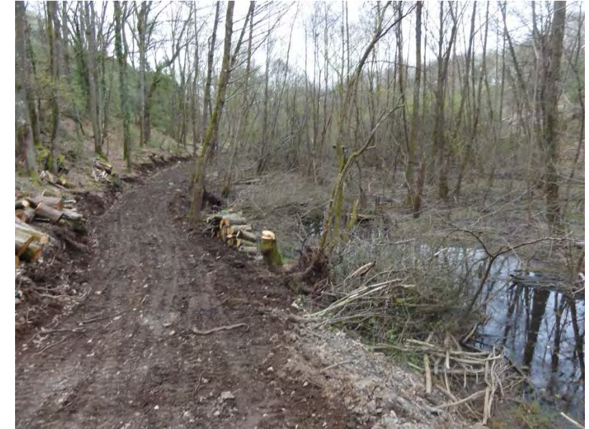
Photo 195 : Rive gauche de l'étang de la Coudre au cours des travaux de N.P.E. (mars 2014, Justine BOIVIN)
