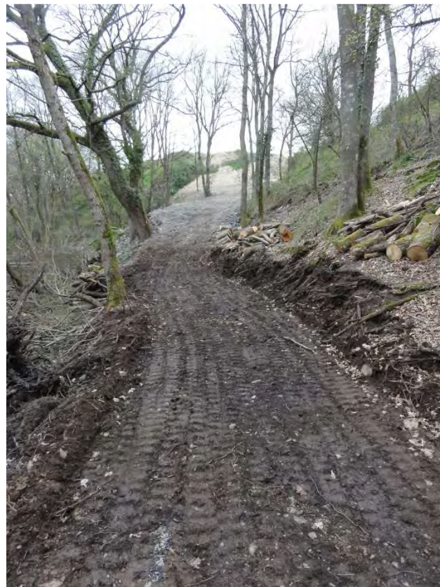
Photo 196 : Rive gauche de l'étang de la Coudre au cours des travaux de N.P.E. (mars 2014, Justine BOIVIN)
