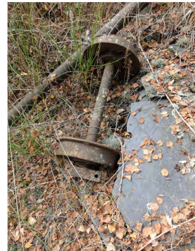
Photo 30 : Station de pompage du terril de Misengrain (septembre 2013, Justine BOIVIN)
