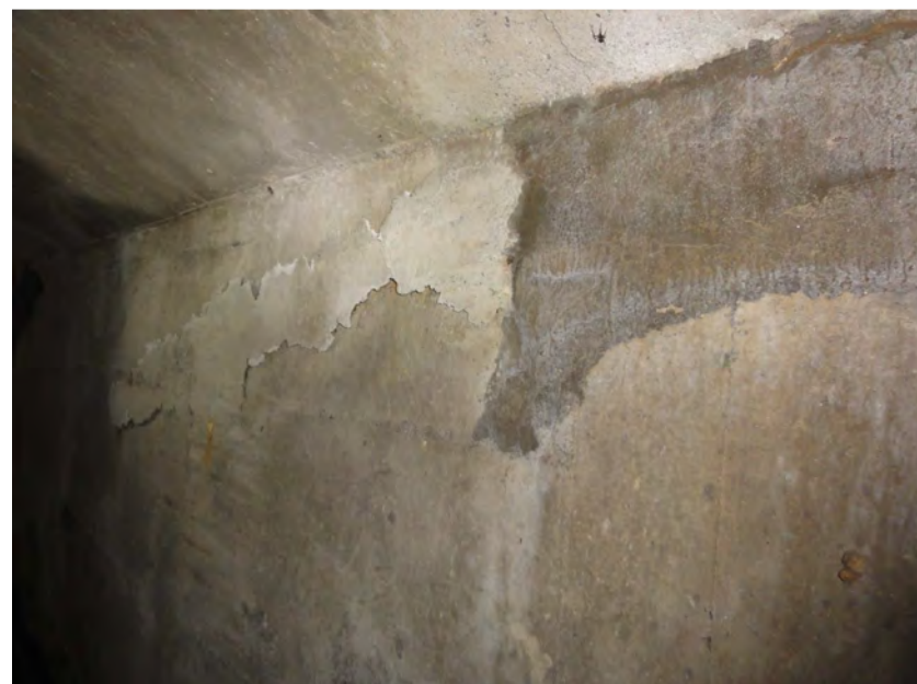
Photo 124 : Tunnel de la Braudaie (octobre 2013, Justine BOIVIN)
