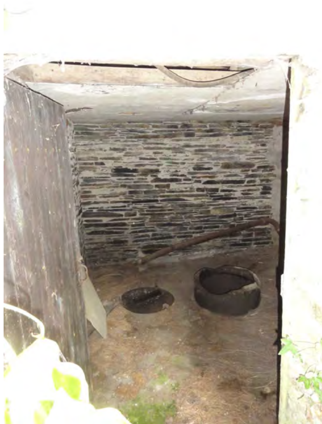
Photo 28 : Station de pompage du terril de Misengrain (septembre 2013, Justine BOIVIN)
