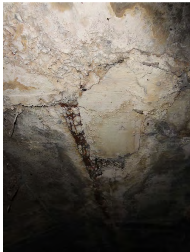
Photo 121 : Tunnel de la Braudaie (octobre 2013, Justine BOIVIN)
