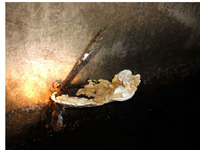
Photo 126 : Tunnel de la Braudaie (octobre 2013, Justine BOIVIN)
