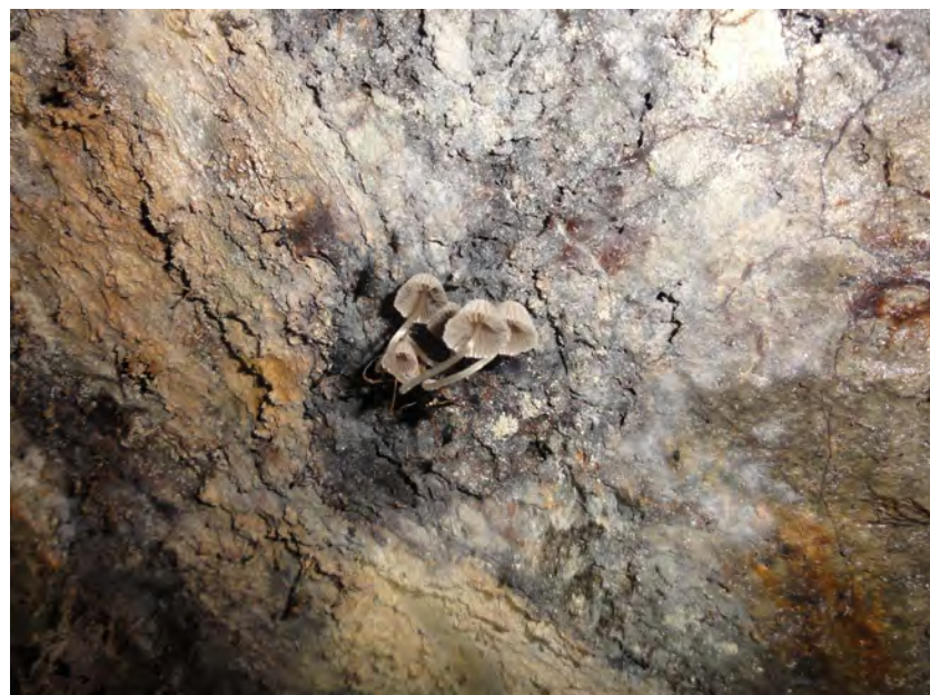
Photo 127 : Tunnel de la Braudaie (octobre 2013, Justine BOIVIN)
