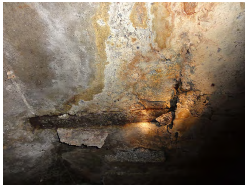
Photo 122 : Tunnel de la Braudaie (octobre 2013, Justine BOIVIN)
