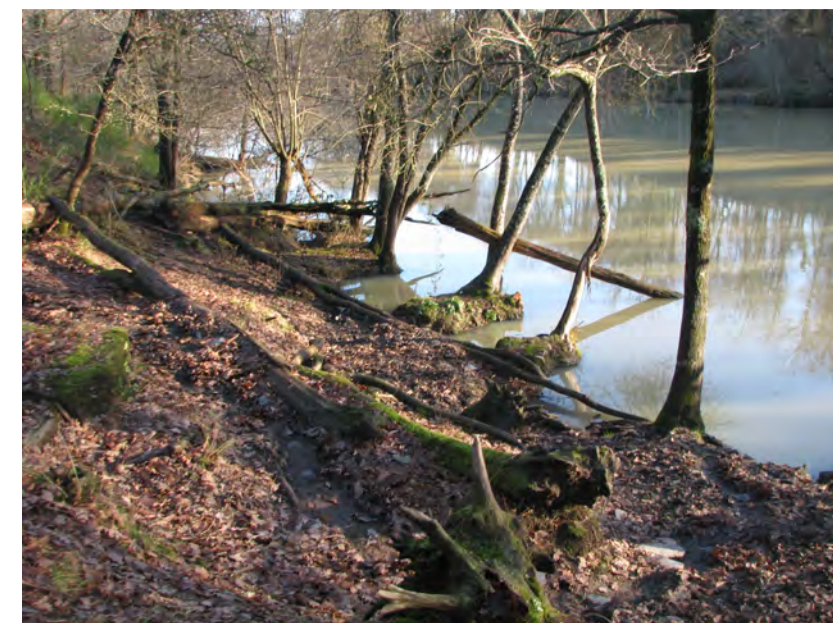
Photo 171 : Rive gauche de l'étang de la Coudre au cours des travaux de N.P.E. (décembre 2013, Justine BOIVIN)
