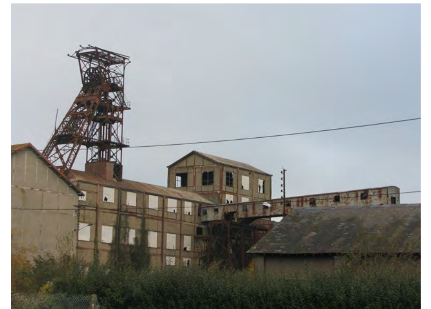
Photo 168 : Carreaux de la mine de fer de Bois II (décembre 2013, Justine BOIVIN)
