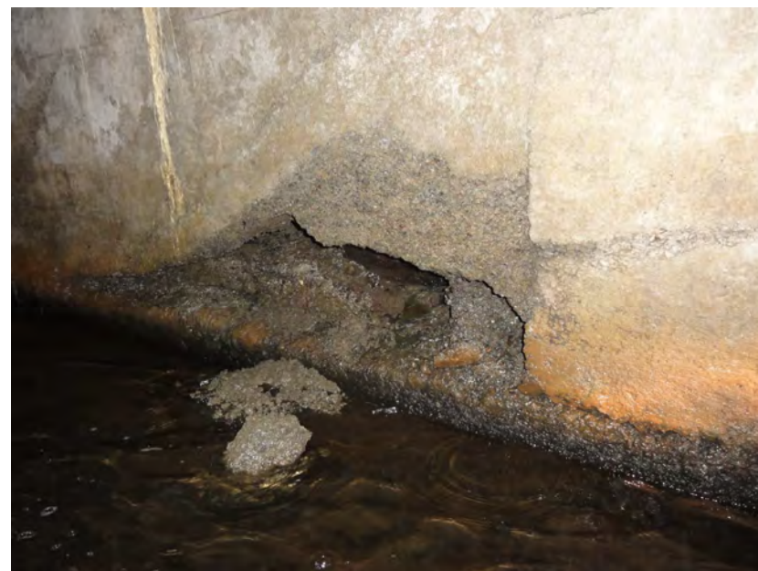
Photo 128 : Tunnel de la Braudaie (octobre 2013, Justine BOIVIN)
