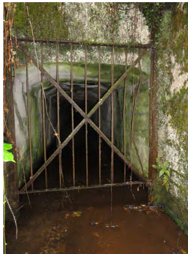
Photo 119 : Entrée amont du tunnel de la Braudaie (octobre 2013, Justine BOIVIN)
