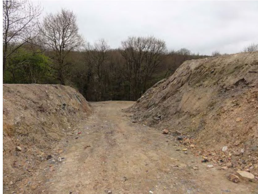
Photo 193 : Rive gauche de l'étang de la Coudre au cours des travaux de N.P.E. (mars 2014, Justine BOIVIN)
