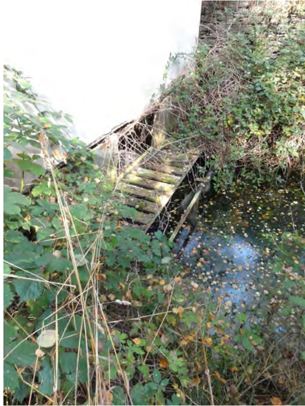
Photo 25 : Station de pompage du terril de Misengrain (septembre 2013, Justine BOIVIN)
