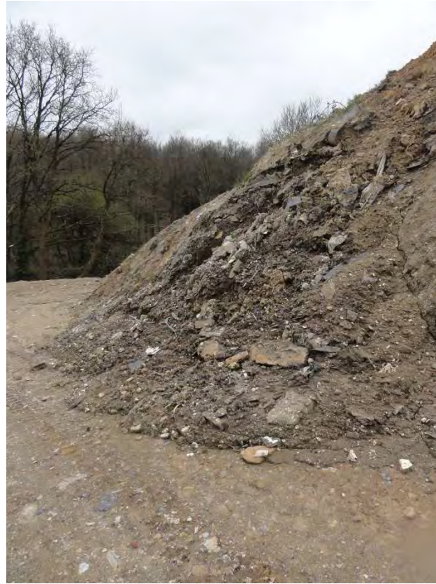
Photo 194 : Rive gauche de l'étang de la Coudre au cours des travaux de N.P.E. (mars 2014, Justine BOIVIN)
