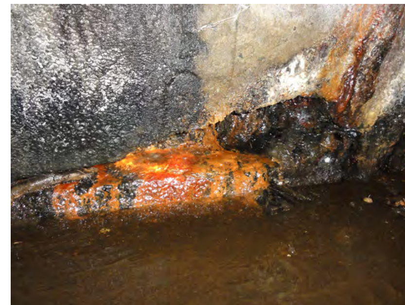
Photo 123 : Tunnel de la Braudaie (octobre 2013, Justine BOIVIN)
