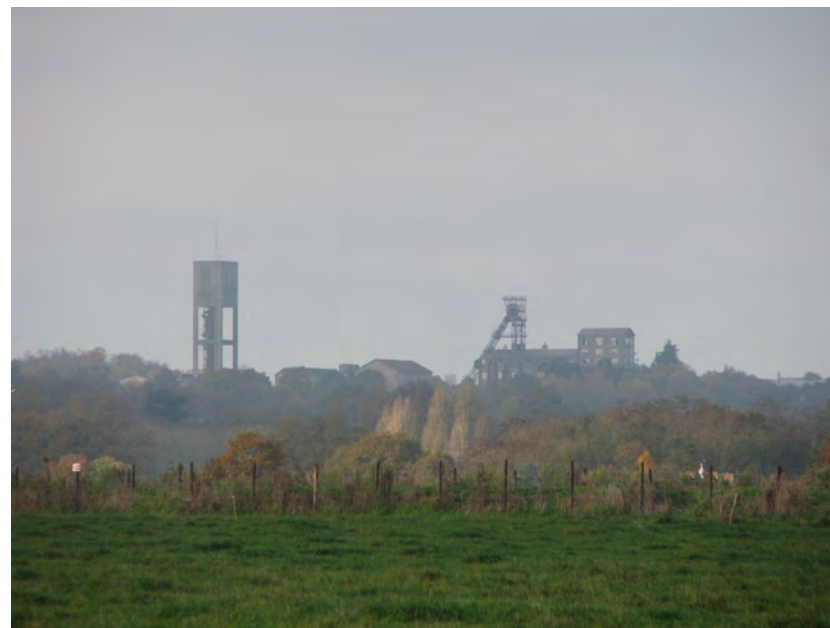
Photo 167 : Carreaux de la mine de fer de Bois II (décembre 2013, Justine BOIVIN)
