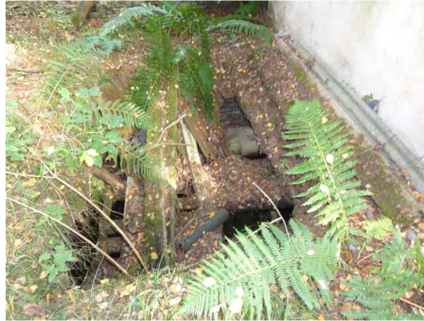
Photo 26 : Station de pompage du terril de Misengrain (septembre 2013, Justine BOIVIN)
