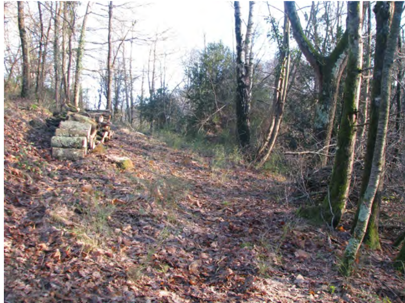
Photo 175 : Rive gauche de l'étang de la Coudre au cours des travaux de N.P.E. (décembre 2013, Justine BOIVIN)
