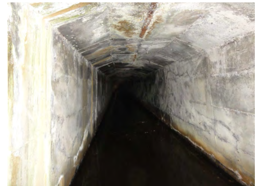
Photo 120 : Tunnel de la Braudaie (octobre 2013, Justine BOIVIN)
