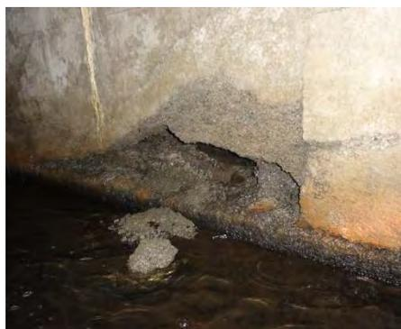
**Figure 6 : Dégât dans le béton du tunnel de la Braudaie (Crédit photo Justine BOIVIN)**
